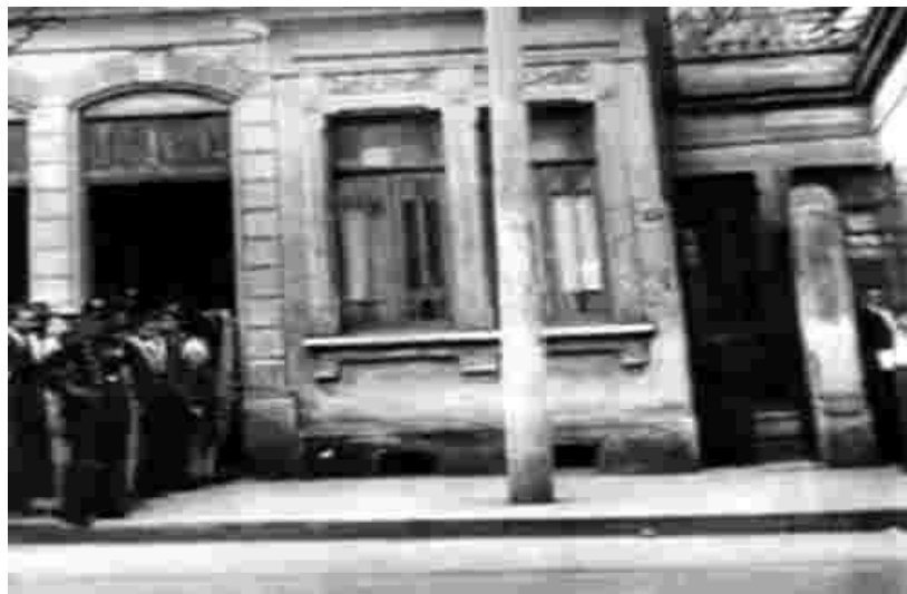
Fachada da casa – Rua Santo Antônio 104.
